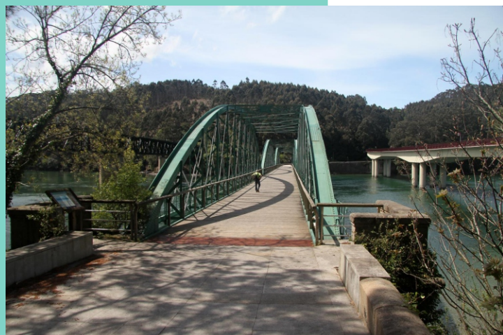
Esteiro do Sor Ponte de ferro sobre o rio Sor, construída em 1901 e recentemente restaurada
